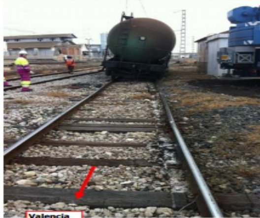
Valencia Zona del descarrilamiento (Fuente: Transfesa Rail)
